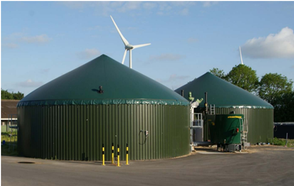
Foto 15: ACRRES biogasinstallatie met WKK waarbij elektriciteit, restwarmte, vrijkomend CO 2 en nutriënten worden gebruikt voor algenkweek in vijvers en reactoren
