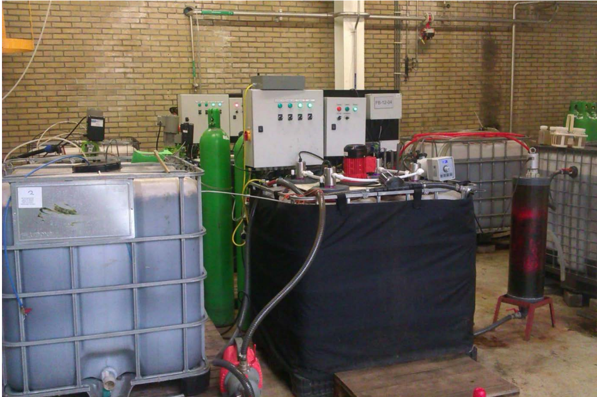
Foto 16: LED algenreactor voor zuivering afvalwater bij een bierbrouwer
