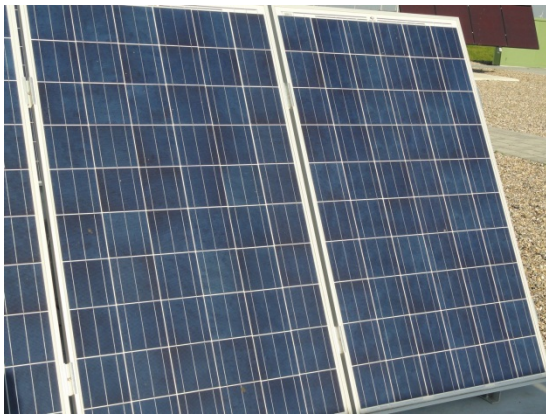
Foto 1: polykristallijn silicium panelen van Solarpark
