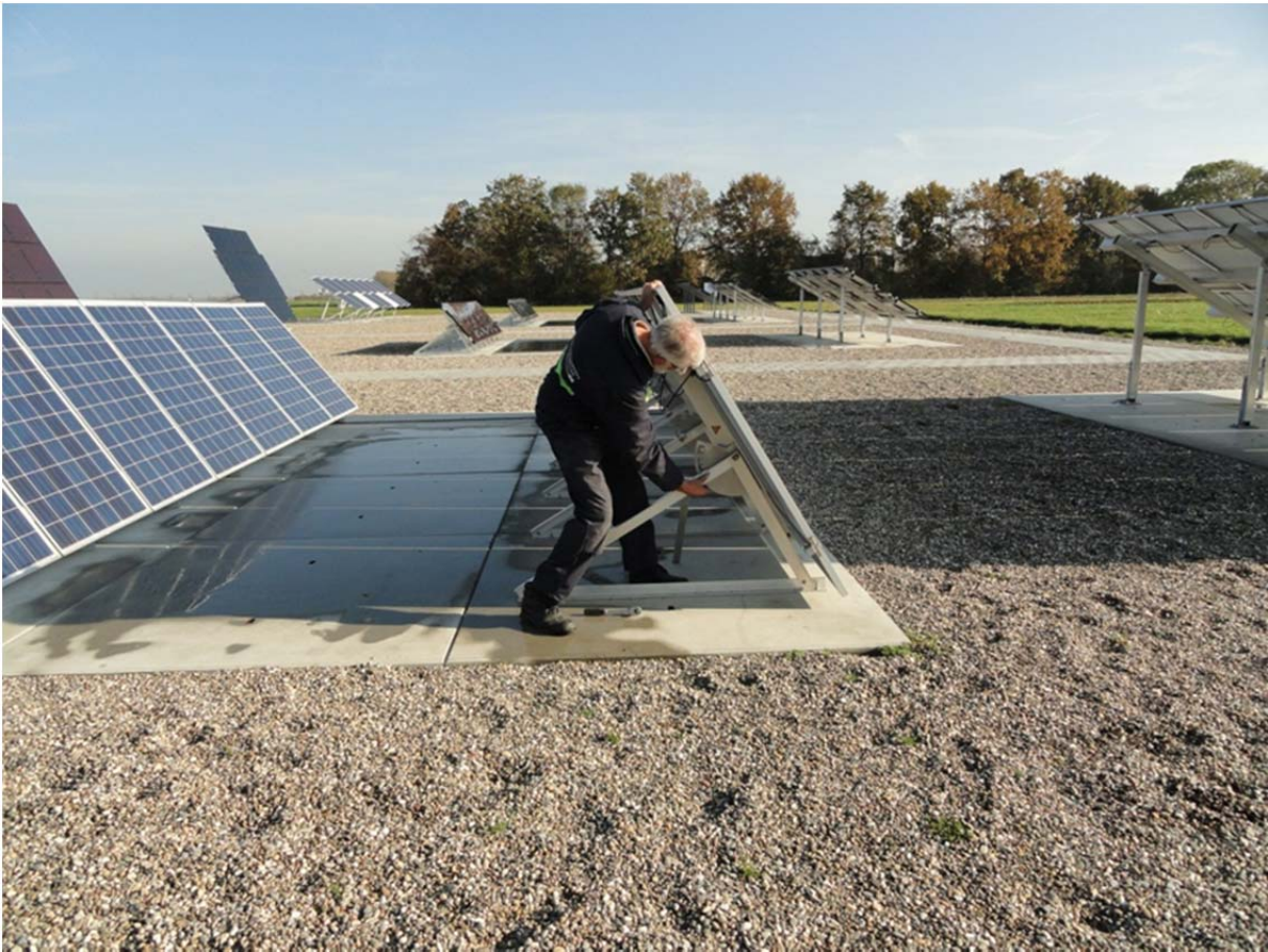
Foto 13: verzetten van de panelen in een stellere stand
