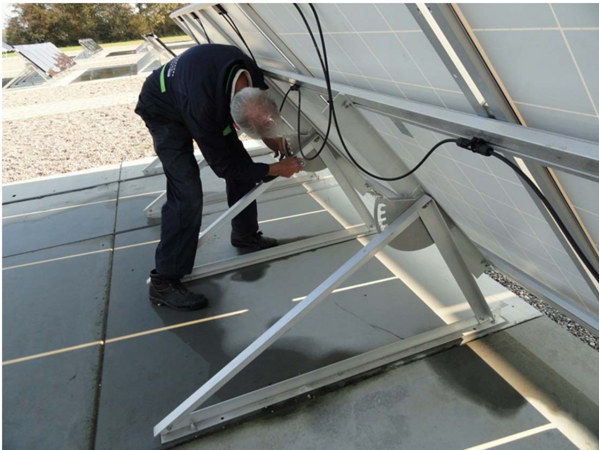
Foto 12: losdraaien van de bouten bij het verstellen van de hellingshoek
