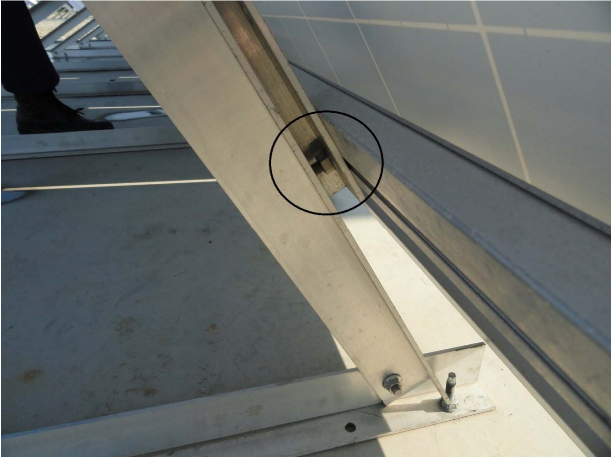
Foto 11: door deze bouten op de variabele opstellingen wordt de ideale hellingshoek van 60° voor november tot en met januari niet bereikt
