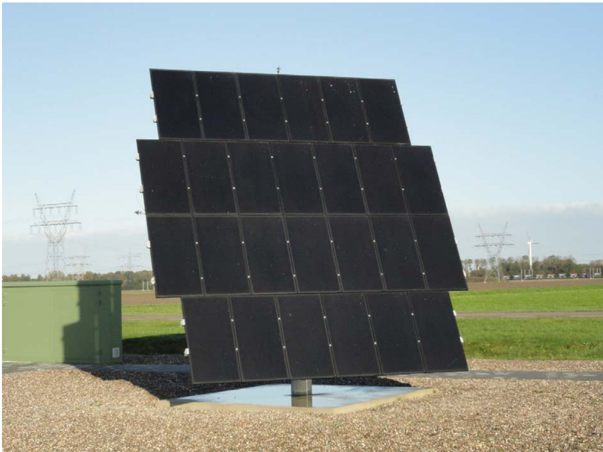
Foto 7: Deger sun-tracker (over 2 assen) met Sulfurcell panelen
