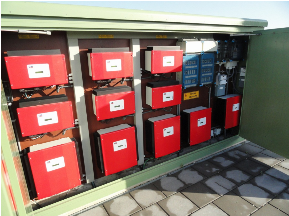
Foto 9: Kast met de SMA-inverters en bruto productiemeters
