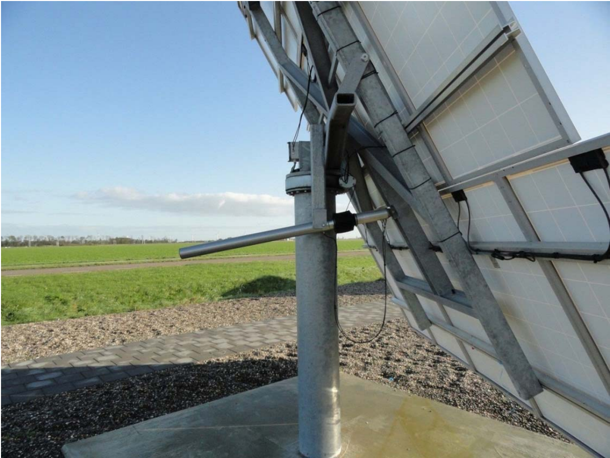
Foto 14: De fundering, draagconstructie en het aandrijfmechanisme van de Deger suntracker
