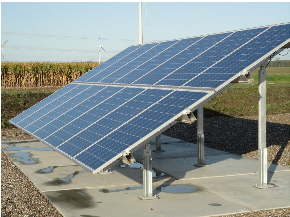
Foto 5: Solarpark panelen in de vaste opstelling
