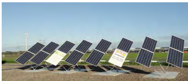
Foto 8: Van der Valk solar-tracker (over 1 as)
