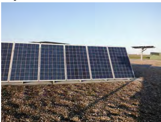
Foto 10: Schaduw van vaste op variabele Solarpark opstelling
