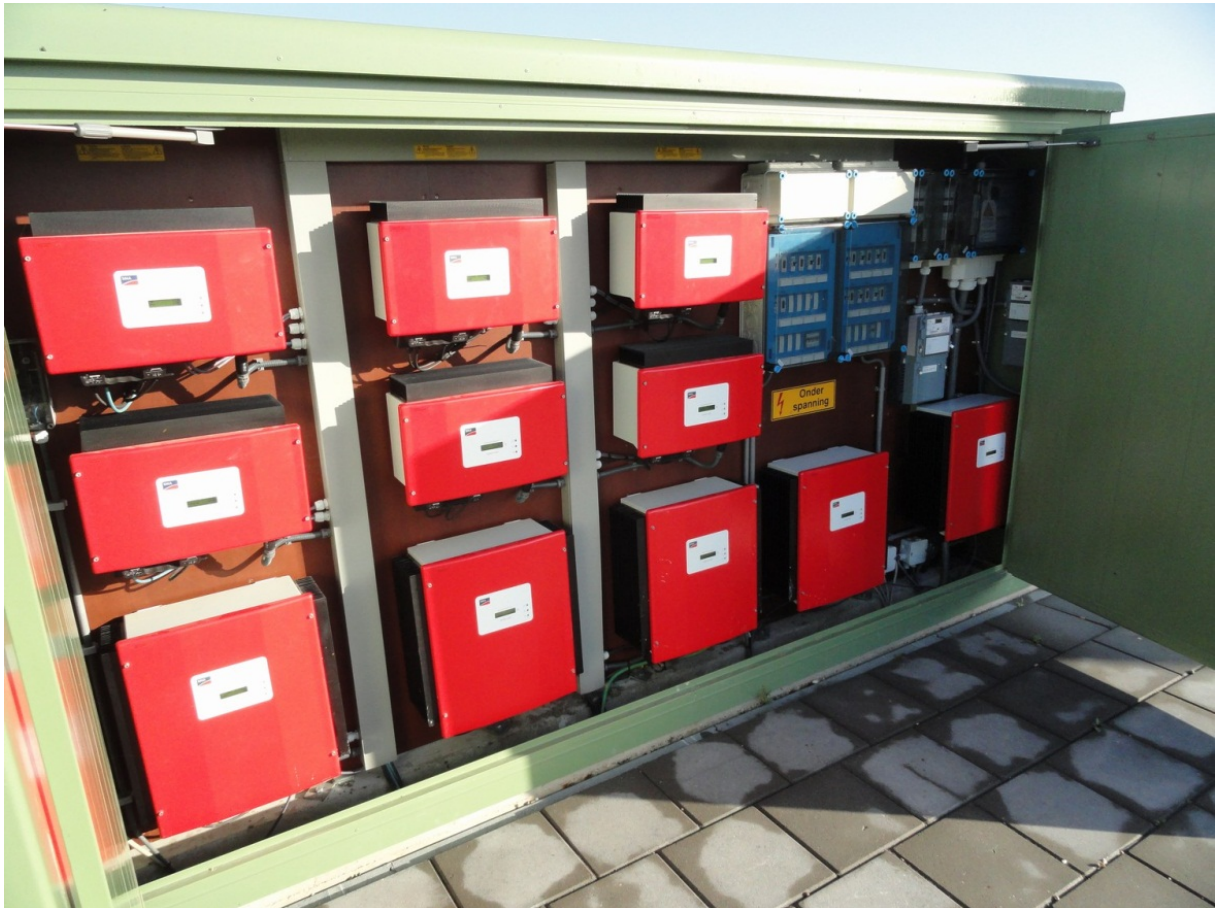
Foto 9: Kast met de SMA-inverters en bruto productiemeters
