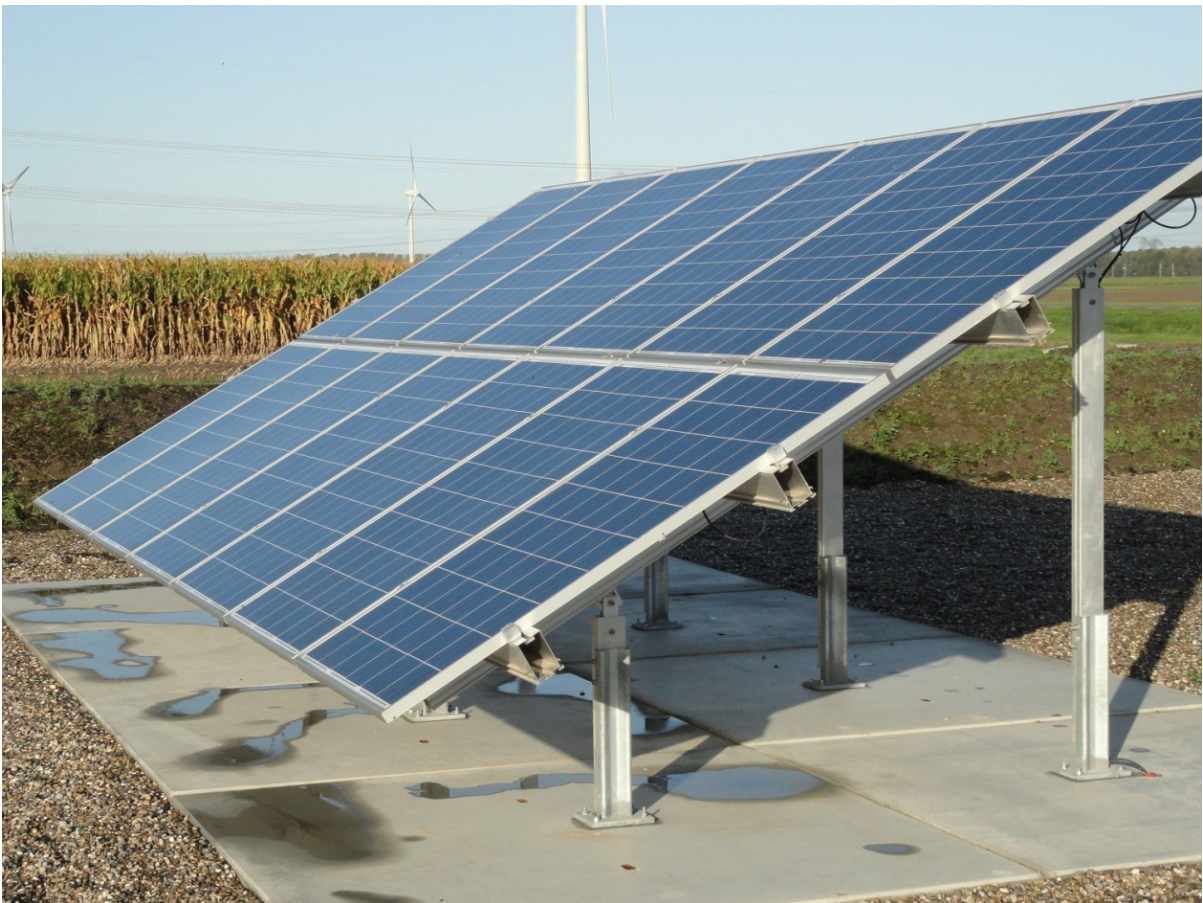
Foto 5: Solarpark panelen in de vaste opstelling
