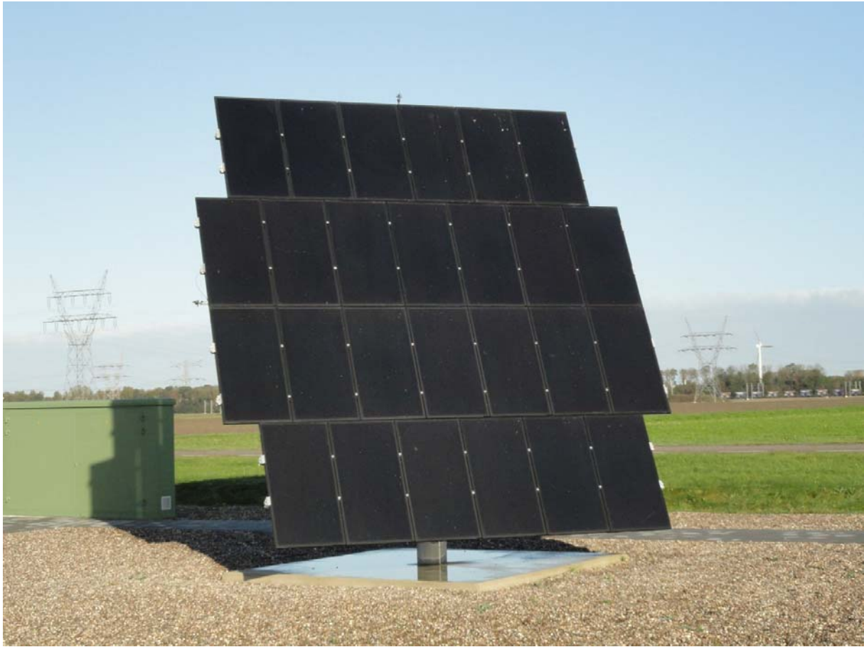
Foto 7: Deger sun-tracker (over 2 assen) met Sulfurcell panelen
